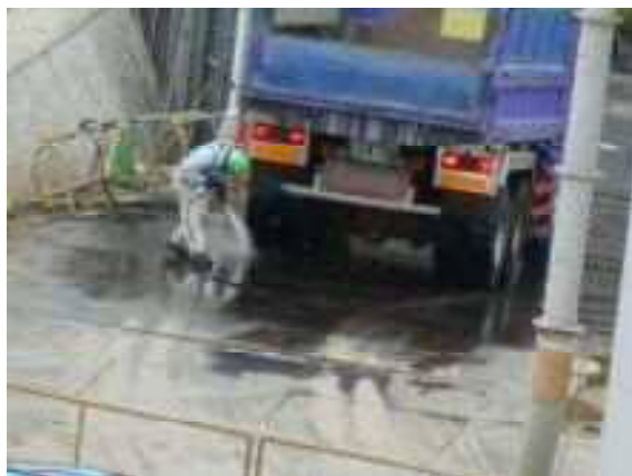
写真 6：落ちた土砂の清掃状況（敷き鉄板）
