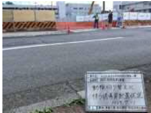
写真 2：歩行者動線切り替えに伴う誘導員配置状況
