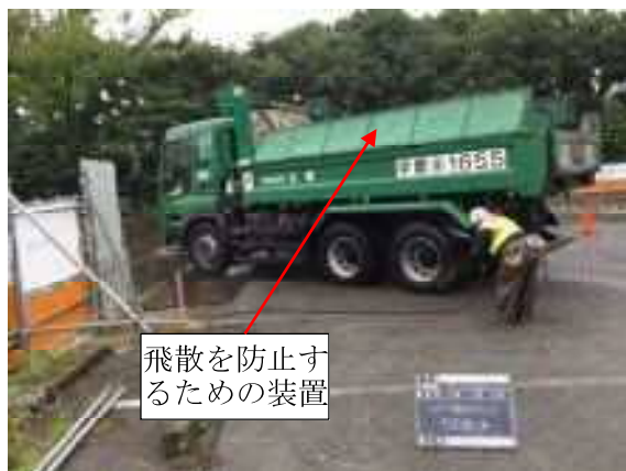
写真 5：落ちた土砂の清掃状況（敷き鉄板）
