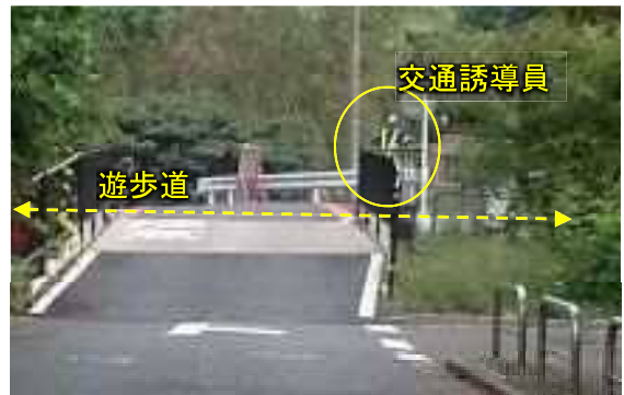
写真 4 : 交通誘導員の配置状況
